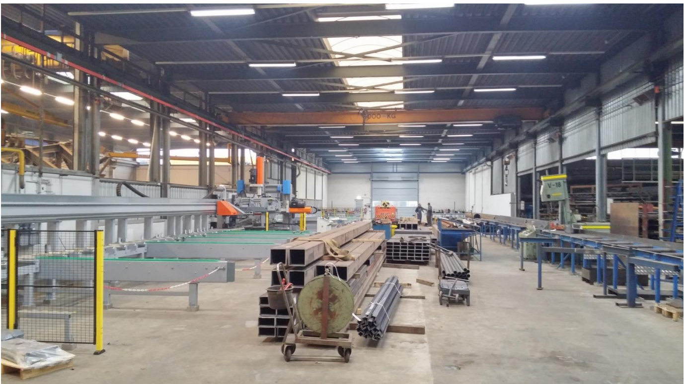
LED Verlichting met bewegingssensoren staalhal II ( gerealiseerd 2015)
