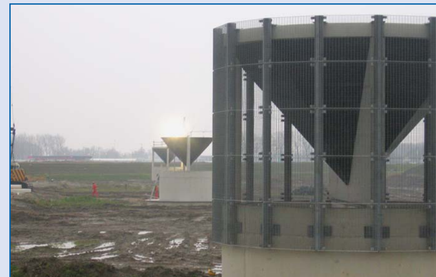
Betonnen luchtschachten met stalen roosterbekleding priemen uit het oer-hollandse landschap.
