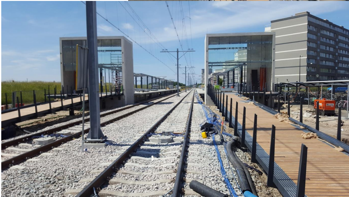
Project: Hoekslijn (ombouw van trein- naar metrostations realisatie 2017)
